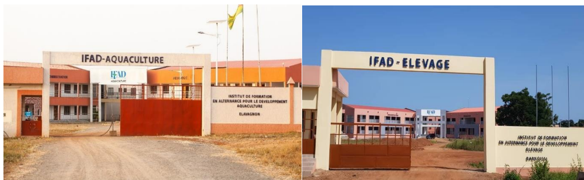
Locaux des IFAD – Bâtiment, Aquaculture et Elevage respectivement à Adjudogomé, Elavagnon, et à Barkoissi
