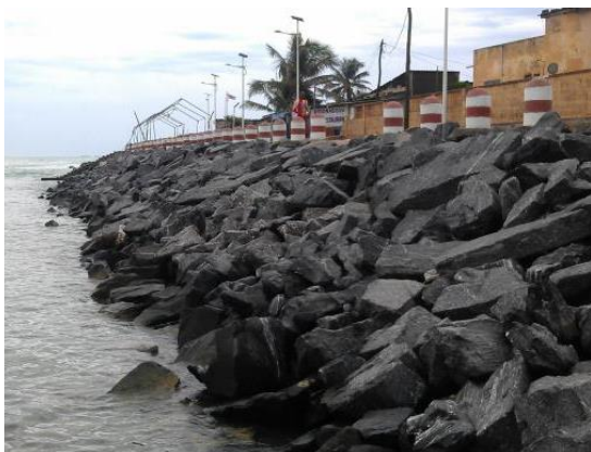
Protection de la côte contre l'érosion côtière
